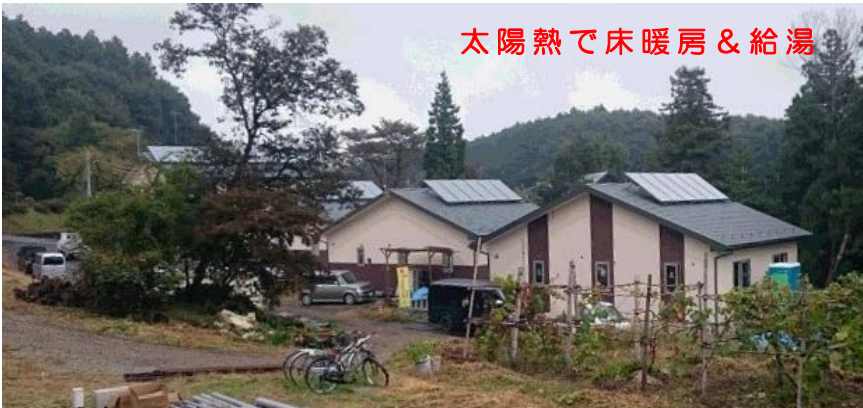
職員住宅 (完成 2015年) 集熱面積 60 m 2 蓄熱床面積 約 280 m 2 貯湯タンク 1,850 L
