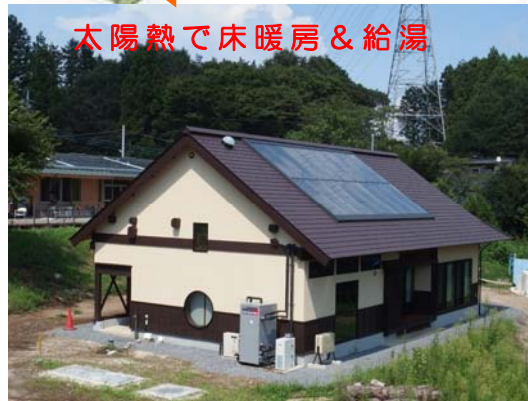
チャペル (完成 2014年) 集熱面積 27.2 m 2 蓄熱床面積 約 80 m 2 貯湯タンク 370 L
