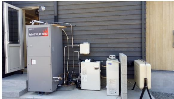
↑ 一般的な補助ボイラーに灯油を用いた事例
