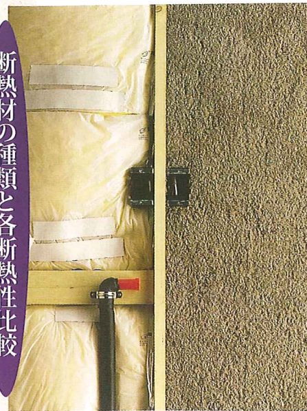
●COCOON断熱材(右)とグラスウール(左) グラスウールに比較して、COCOON断熱材 の充填密度の高さが良く分かります。
